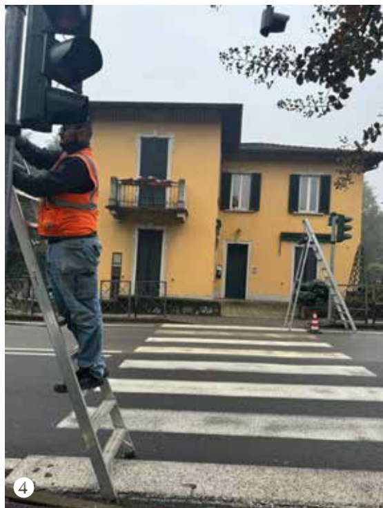
4 La manutenzione straordinaria dell'impianto semaforico sull'incrocio tra via Bergamo e via del Fontanile.
