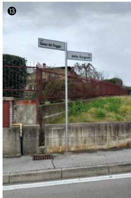
13 Ripristino e sostituzione della segnaletica verticale.
