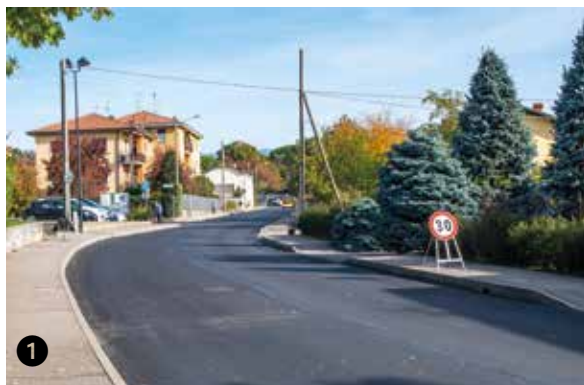
Foto 1 e 2: I lavori di asfaltatura e la realizzazione della segnaletica orizzontale in via San Francesco. (foto di G. Bonfanti)
