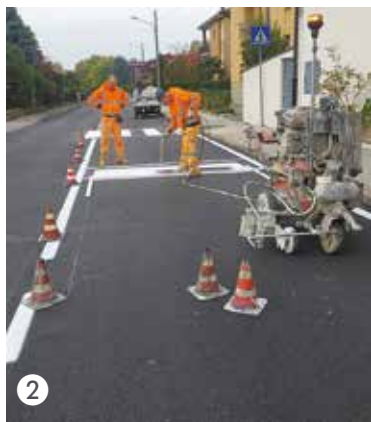
foto 3: Gli attraversamenti pedonali rialzati realizzati in via Monza, utili al rallentamento dei veicoli in transito
