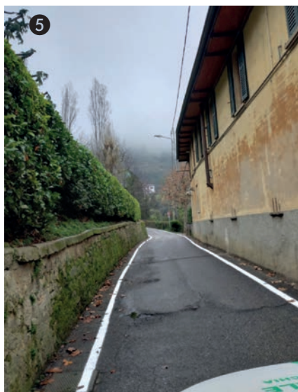
5 Rifacimento della segnaletica orizzontale in via del Pertevano.
